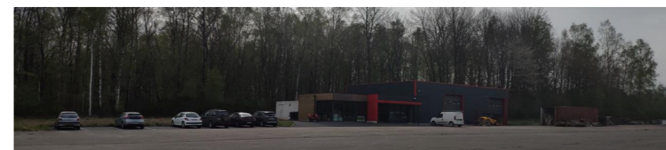
Bâtiment Acacia (source : Néodyme)
