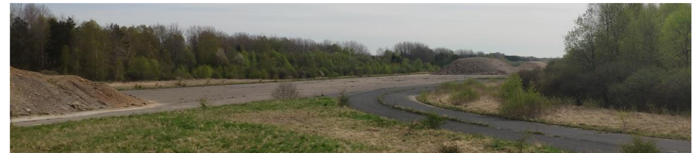
Planéité au droit des parcelles d'implantation et talus de déblais sur la piste Nord (source : Néodyme)
