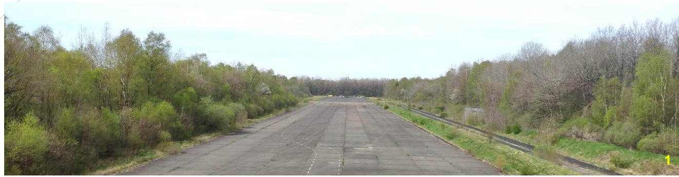
Vue depuis le merlon à l'Ouest vers la pointe Ouest-Nord (source : Néodyme)
