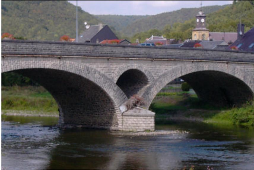
**Photo 5** - Flottants laissés par une crue de la SEMOY sur une des piles du pont de la RD 31 à HAUTES RIVIÈRES
