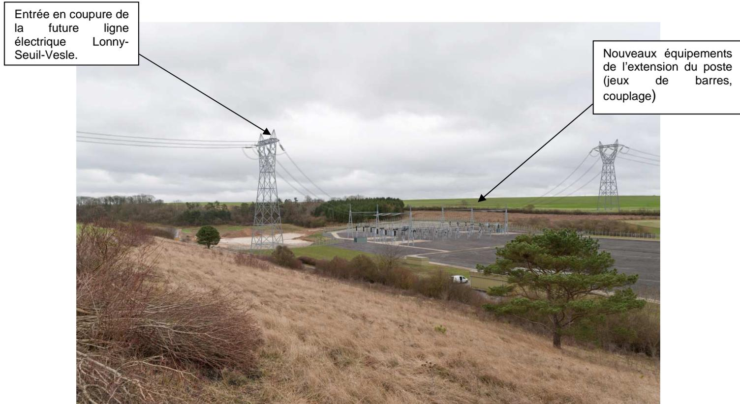
*Illustration de l'extension du poste. Le 2<sup>ème</sup> circuit du projet de la future ligne électrique Lonny-Seuil-Vesle qui surplombe uniquement le poste n'est pas représenté ici afin de visualiser le talus situé au sud du poste*
