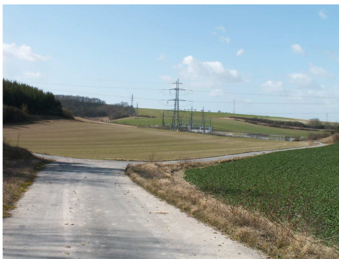
Poste existant de Seuil
