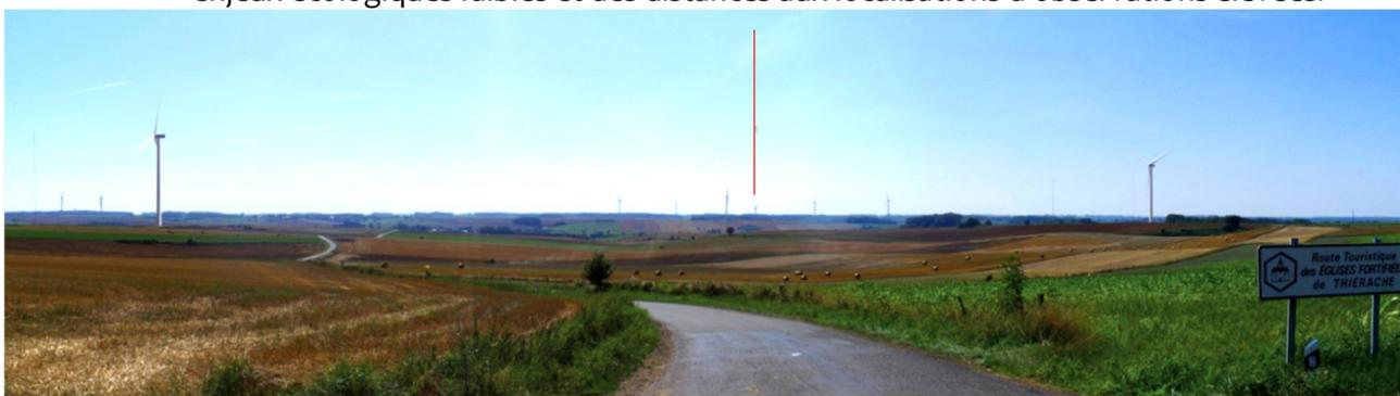
Le projet concerne 1 éolienne tripales de couleur blanche (ou RAL 9003, 9010, 9016, 7035 ou 7038), d'une puissance nominale unitaire de 3 MW ou 3,3 MW et de gabarit 150 mètres en bout de pales. Ce projet comportera également l'installation d'un poste électrique (poste de livraison).
