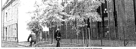
Le syndicat souhaite que la santé des agents passe avant le bâtiment. PHILIPPE GAUCHER
