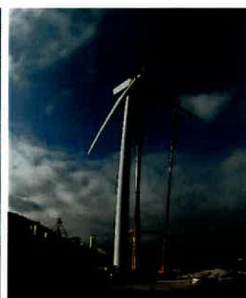
Le démantèlement de l'éolienne ECO74 a été réalisé à l'aide d'une grue et « pale par pale » selon une méthodologie proche de celle d'une construction nouvelle. Le coût de l'acheminement d'une grue sur site, de la mise à disposition d'un technicien et la coordination du démontage a été de l'ordre de 67 000 €.
