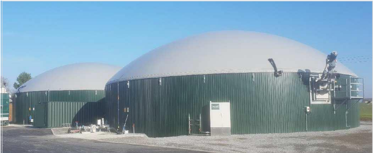
Figure 29 : Exemple de Digesteur et post-digesteur bardés avec des tôles
