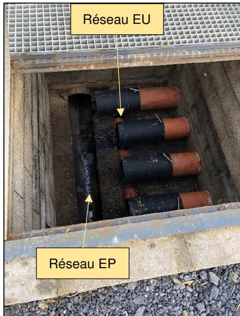
Des vannes manuelles permettront d'avancer ou de reculer les arrivées d'eau pour les orienter soit vers le réseau eaux usées soit vers le réseau eaux pluviales.
