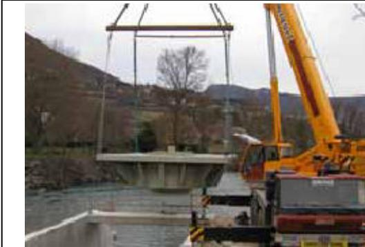
*Figure 18 : Photo montrant la pose de la turbine par grue (site de Millau)<sup>4</sup>*
