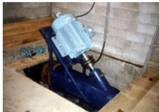
Figure 14 : Photo montrant la génératrice en configuration inclinée
