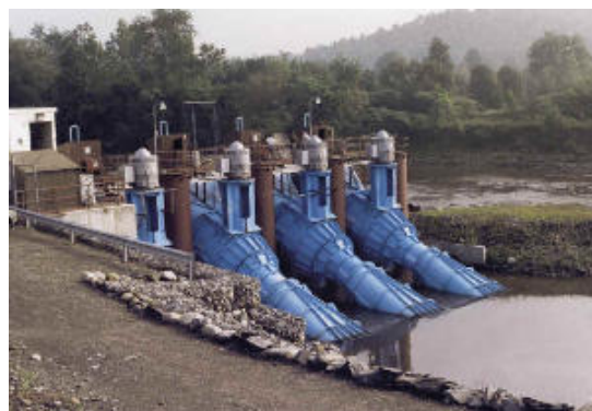
Figure 15 : Photo montrant 3 groupes Kaplan inclinés de puissance 180 kW
