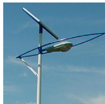
L'installation photovoltaïque permet de s'affranchir d'un raccordement au réseau pour une consommation annuelle très faible (exemple de l'horodateur). Eviter le raccordement au réseau signifie d'une part s'affranchir des tranchées et d'autre part ne pas avoir à payer un abonnement finalement cher pour l'équipement alimenté.
