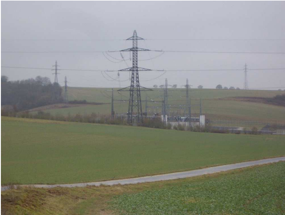
Structure actuelle du poste de Seuil
