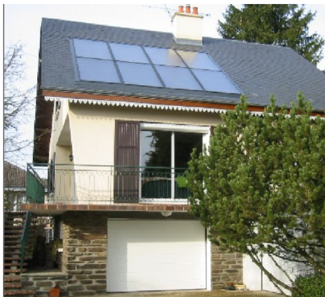
Solaire thermique pour l'habitat individuel (source : Erasun)
