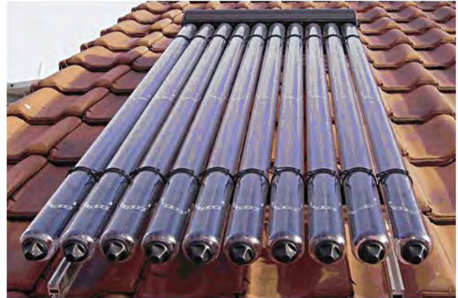
Figure 3 : capteurs solaires thermiques Gauche : tube sous vide ; Droite : chauffe-eau solaire individuel
