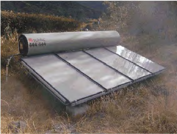
Figure 3 : capteurs solaires thermiques Gauche : tube sous vide ; Droite : chauffe-eau solaire individuel
