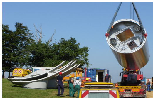
Parc éolien de Vaux les Mouzon en construction (source : DDT08)
