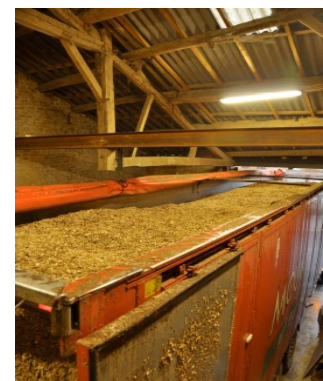
Un réseau de chaleur rural (source : Acacia)
