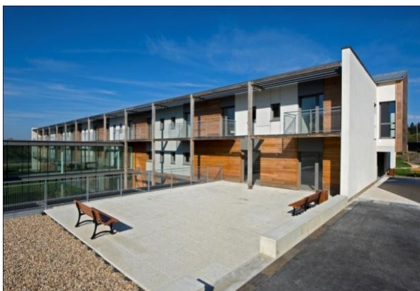
EHPAD des Hauts Buttés à Monthermé (source : Atelier Matières d'Architecture)
