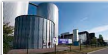
Installation de méthanisation
