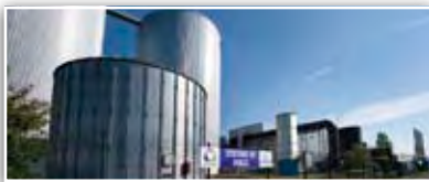
Installation de méthanisation
