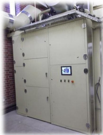
Façade arrière et porte de service
