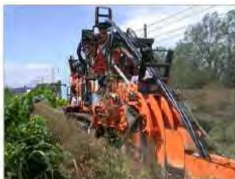
Engin utilisé pour le creusement de la tranchée sur environ 1 m de profondeur
