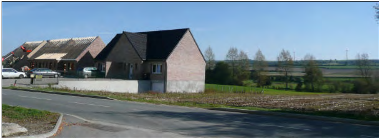
Photo 4 : construction de maison neuve à Renty avec éoliennes en arrière plan – source : CEE
