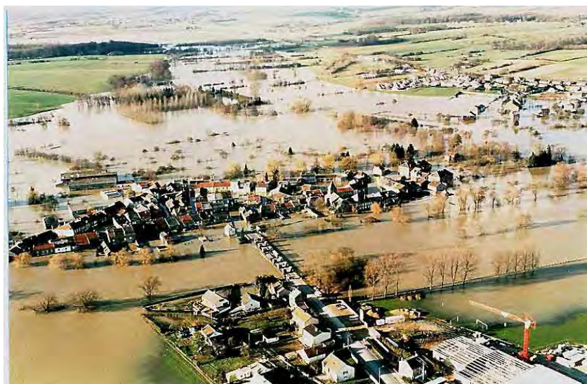
Warcq - crue de 1993
