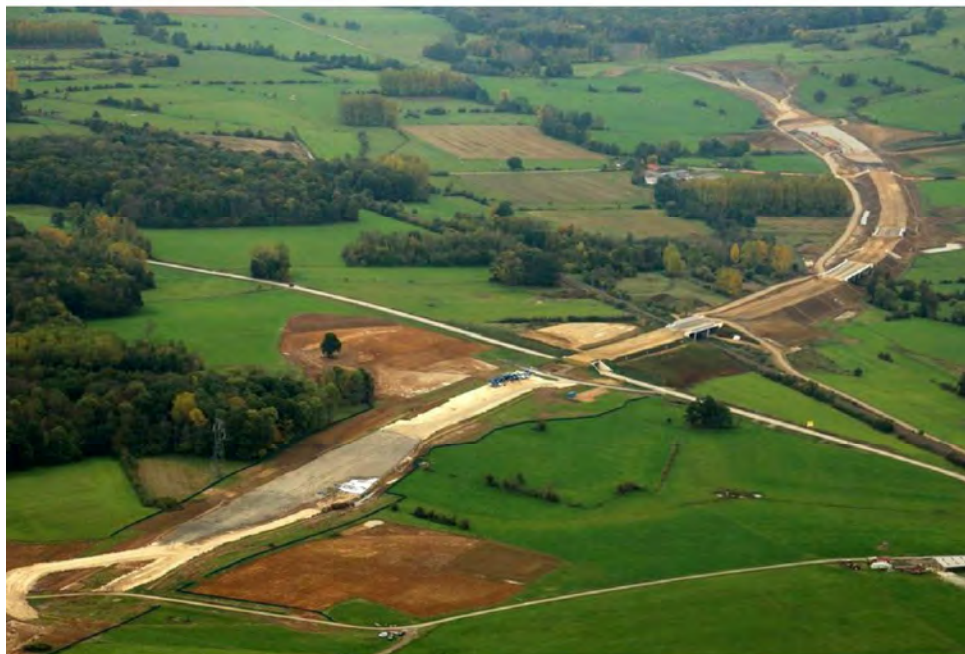
A304 en travaux
