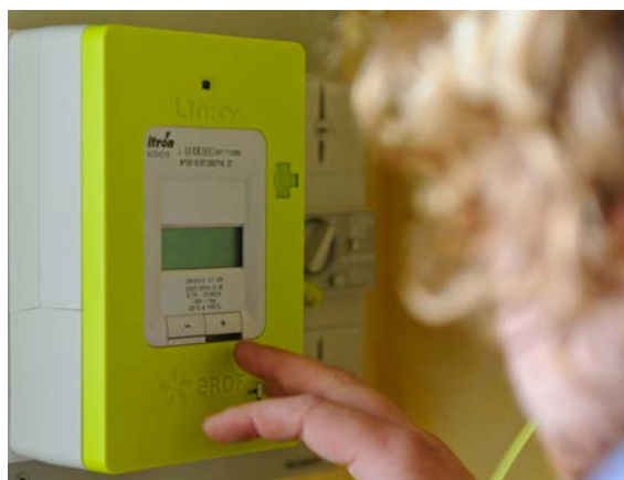
Mise en service de compteur Linky
