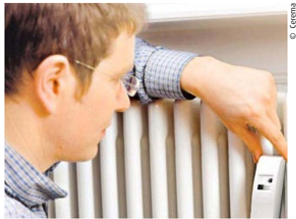
Répartiteur électronique permettant l'estimation de la consommation de l'émetteur de chaleur
