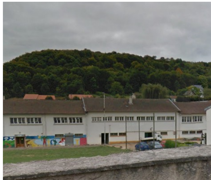
Façade nord de l'école - Source : Google maps
