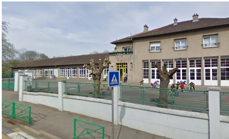
Façade sud de l'école - Source : Google maps
