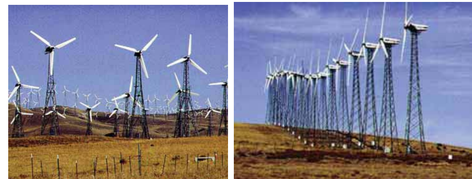
Exemple d'ancienne éolienne à mât en treillis avec une forte densité d'implantation
