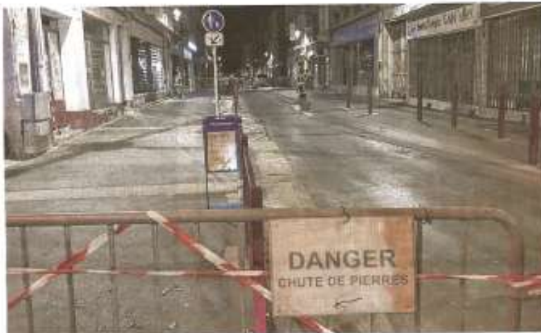
Classement qui menace de s'effondrer depuis au moins six mois est situé dans le secteur concerné par le PSMV. Carole Babart
