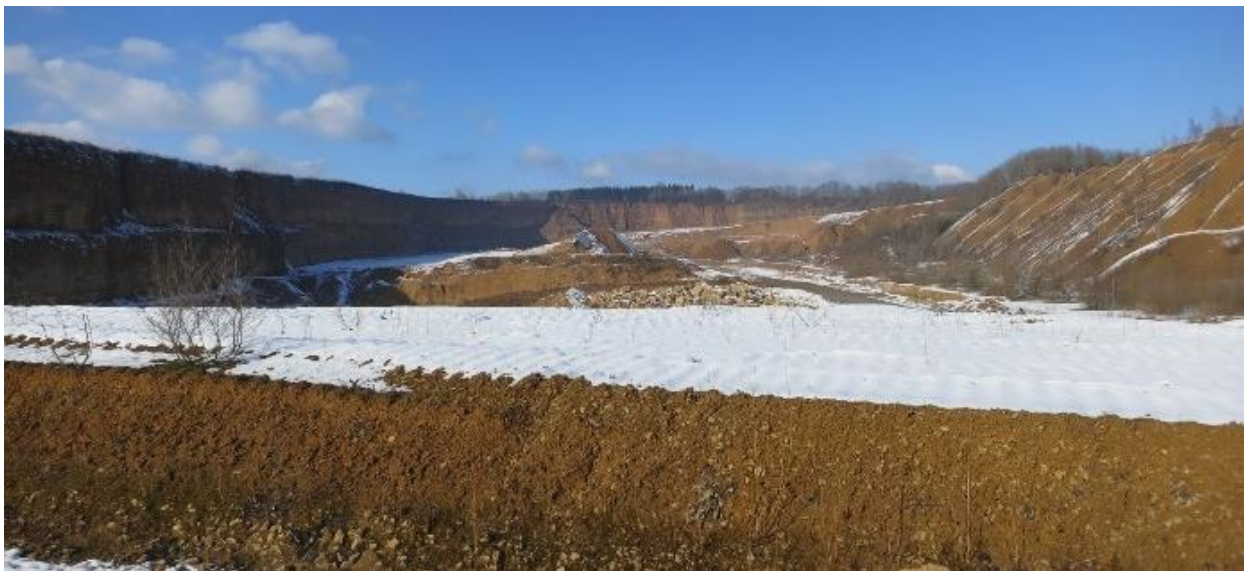
Figure 6 : Vue sur la zone à remblayer
